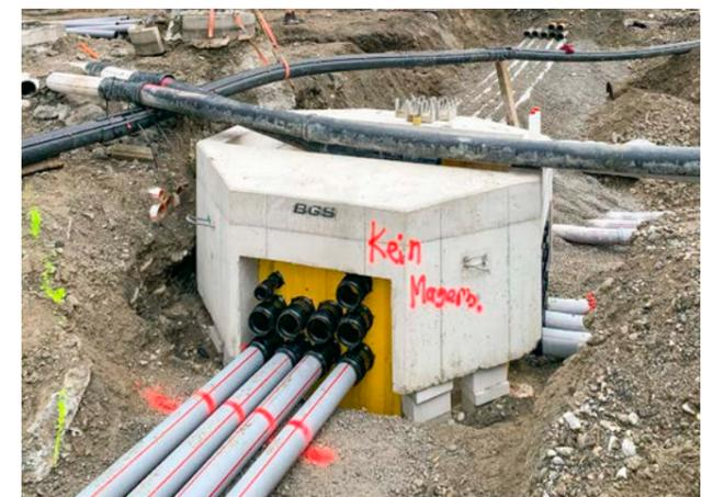
Neubau eines Kreuzungsschachts für Elektroleitungen
