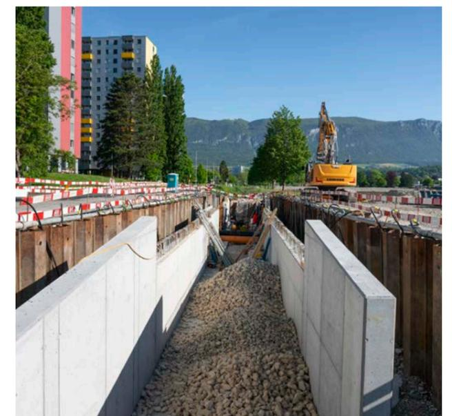
*Ausbildung Wasserlauf bevor die Deckenplatte beim Durchlass erstellt wird*
