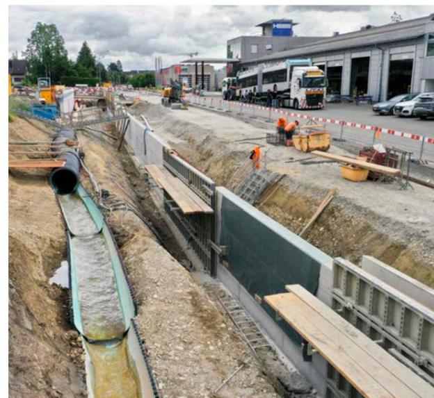
*Neubau Stützmauer mit temporärem Bachlauf*
