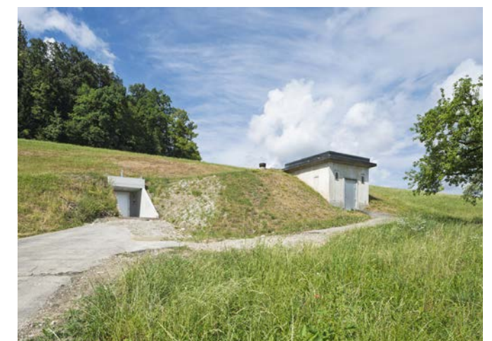
Die im Hang eingebetteten Zugänge zum sanierten Reservoir (links) und ausser Betrieb genommenen alten Reservoir (rechts)
