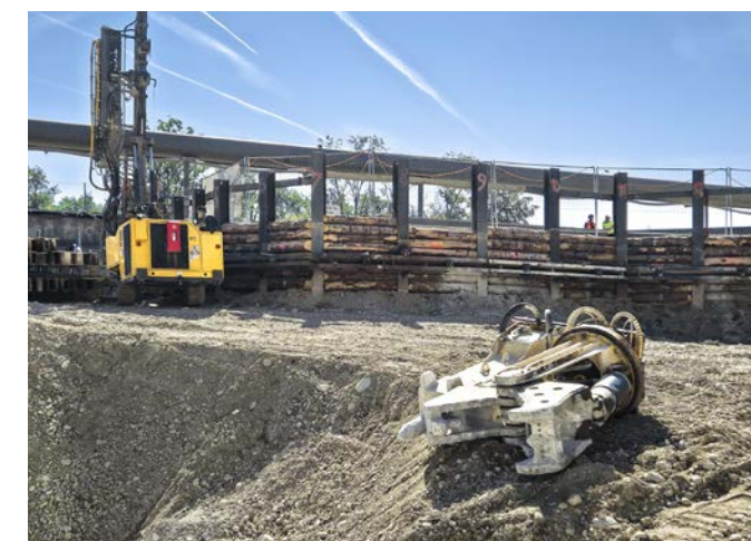
Ausführung der rückverankerten Rühlwand zur Sicherung der Anlieferungsebene
