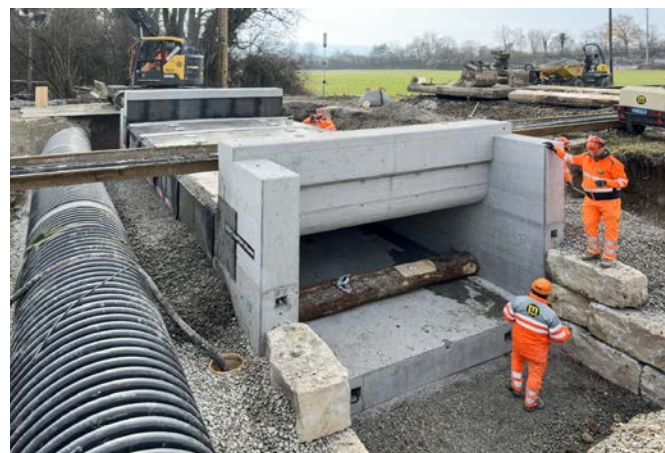
Arbeiten an den Natursteinmauern des Einlaufbauwerks der versetzten Elemente des Bachdurchlasses Haagbach
