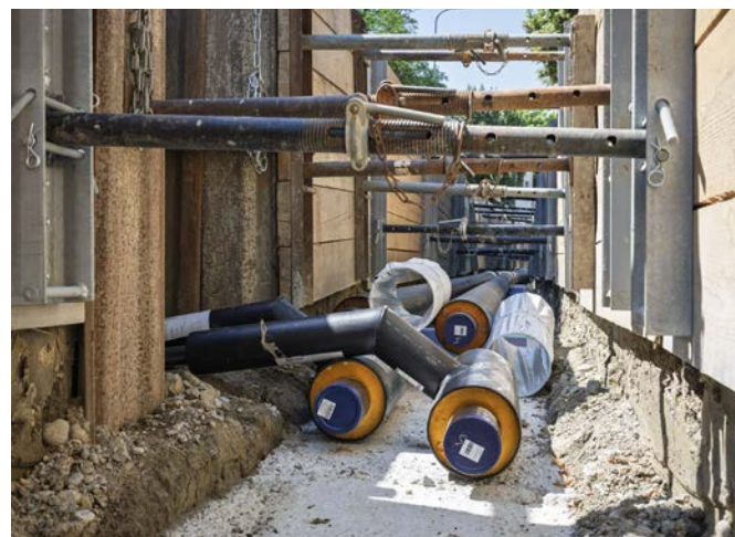
Einbau Fernwärme (Vor- und Rücklauf) im gespriessten Graben
