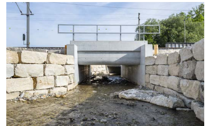
Übergang des neuen Abschnitts mit Blocksteinmauer als HWS-Massnahme zum neu erstellten SBB-Durchlass
