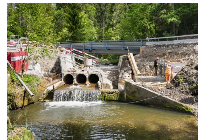
Temporäre Bauelemente: Hilfsbrücke und provisorische Wasserhaltung der Rotache in drei Stahlrohren
