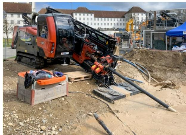
Bohrgerät für HDD-Bohrung (Spülbohrung)
