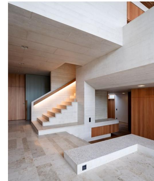
*In Sichtbeton ausgeführte Tragstruktur inklusive Erschliessung ins Sockelgeschoss*
