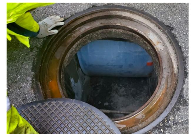
*Blick auf den eingebauten Schlauchliner vor dem Öffnen und Einbinden in den Schacht*
