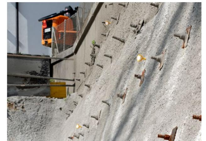
Nagelwand mit mehreren Messpunkten
