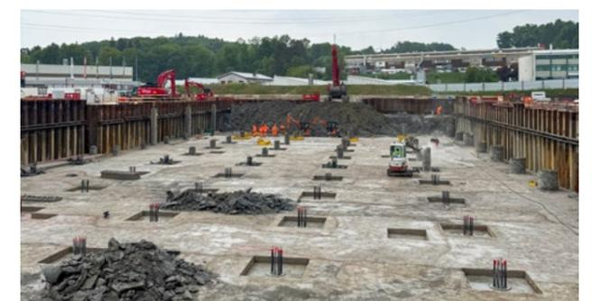
*Pfahlfundation, verankerte Spundwand als Baugrubenabschluss*
