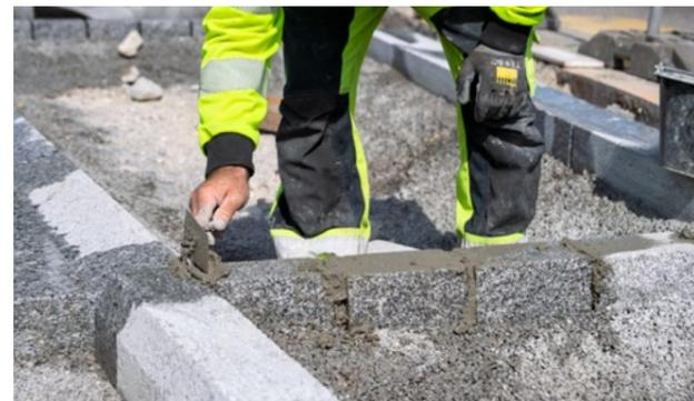
*Ausfugarbeiten an der neu versetzten Besteinung*
