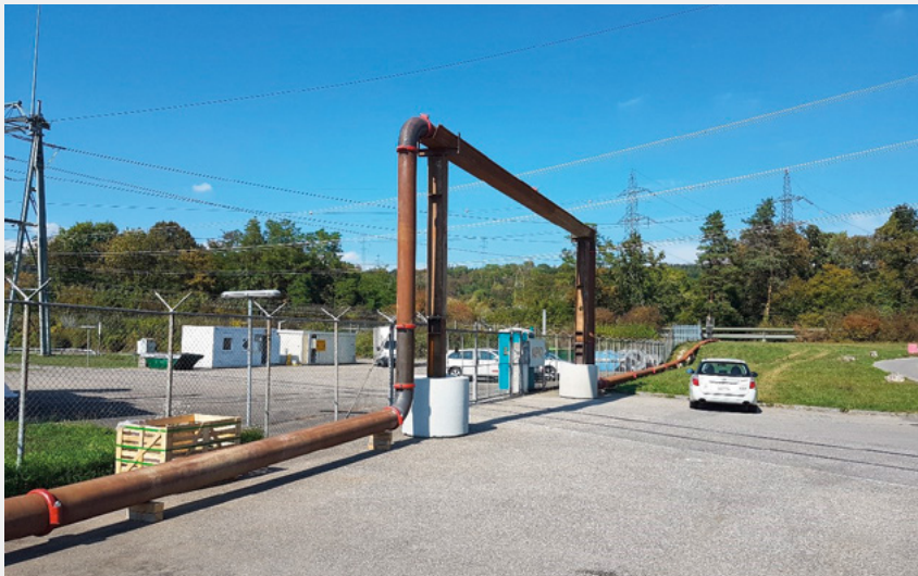
Fig. 4 Provisorische Ablaufleitung NW250 vom GWPW Aarenfeld in die Aare für den Grosspumpversuch mit einer Fördermenge von 10000l/min. (BSB + Partner AG)
