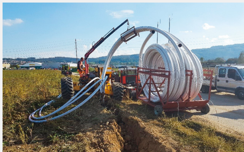
Fig. 2 Einpflügen der Kabelschutzrohre für die Erschliessung des GWPW Aarenfeld. (BSB + Partner AG)
