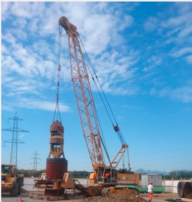
Fig. 10 Seilbagger mit Verrohrungsmaschine zur Ausführung der Greiferbohrung mit Durchmesser 2 m. (Jäckli Geologie AG)
