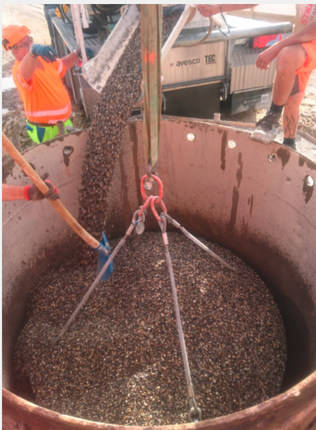
Fig. 11 Einbringen der Filterkiesschüttung. (Jäckli Geologie AG)
