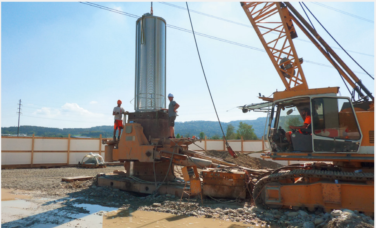
Fig. 7 Einbau des Wickeldrahtfilters.
