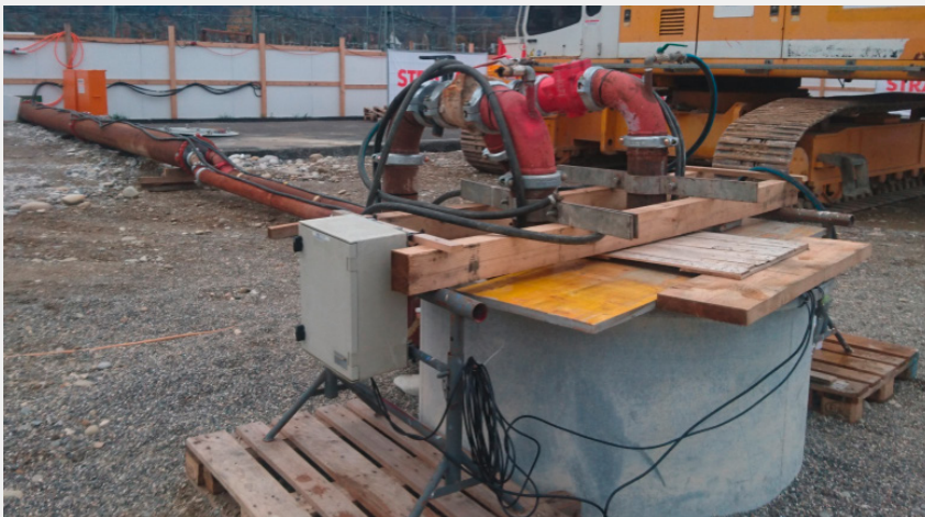
Fig. 13 Pumpversuchseinrichtung mit Förderleistung 10 000 l/min.
