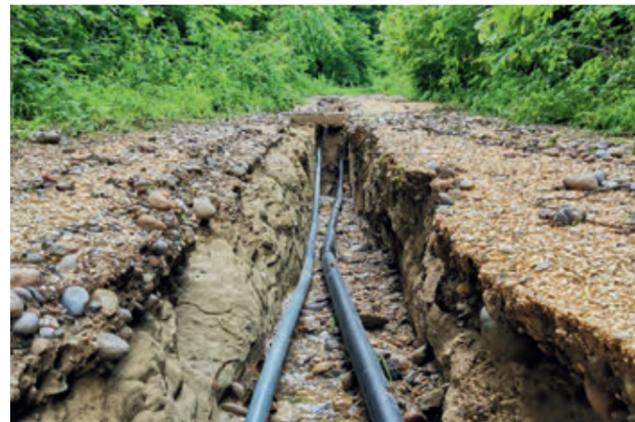
Erosion im Flurweg nach Starkregen 2021
