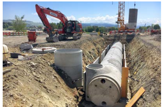
Schmutzwasserretention mit systemintegrierter Speicherröhre
