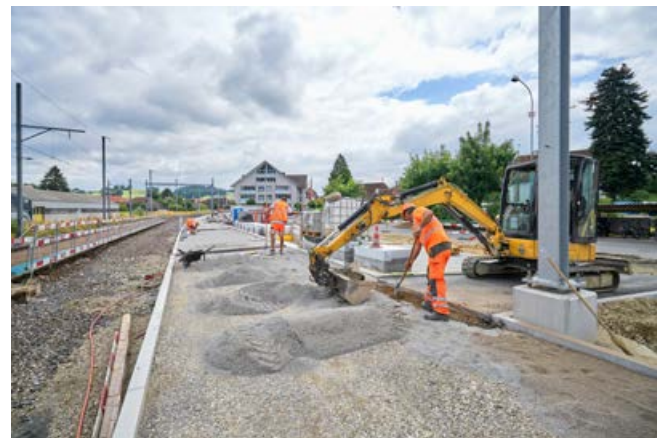
Entstehung Perron Rohrbach
