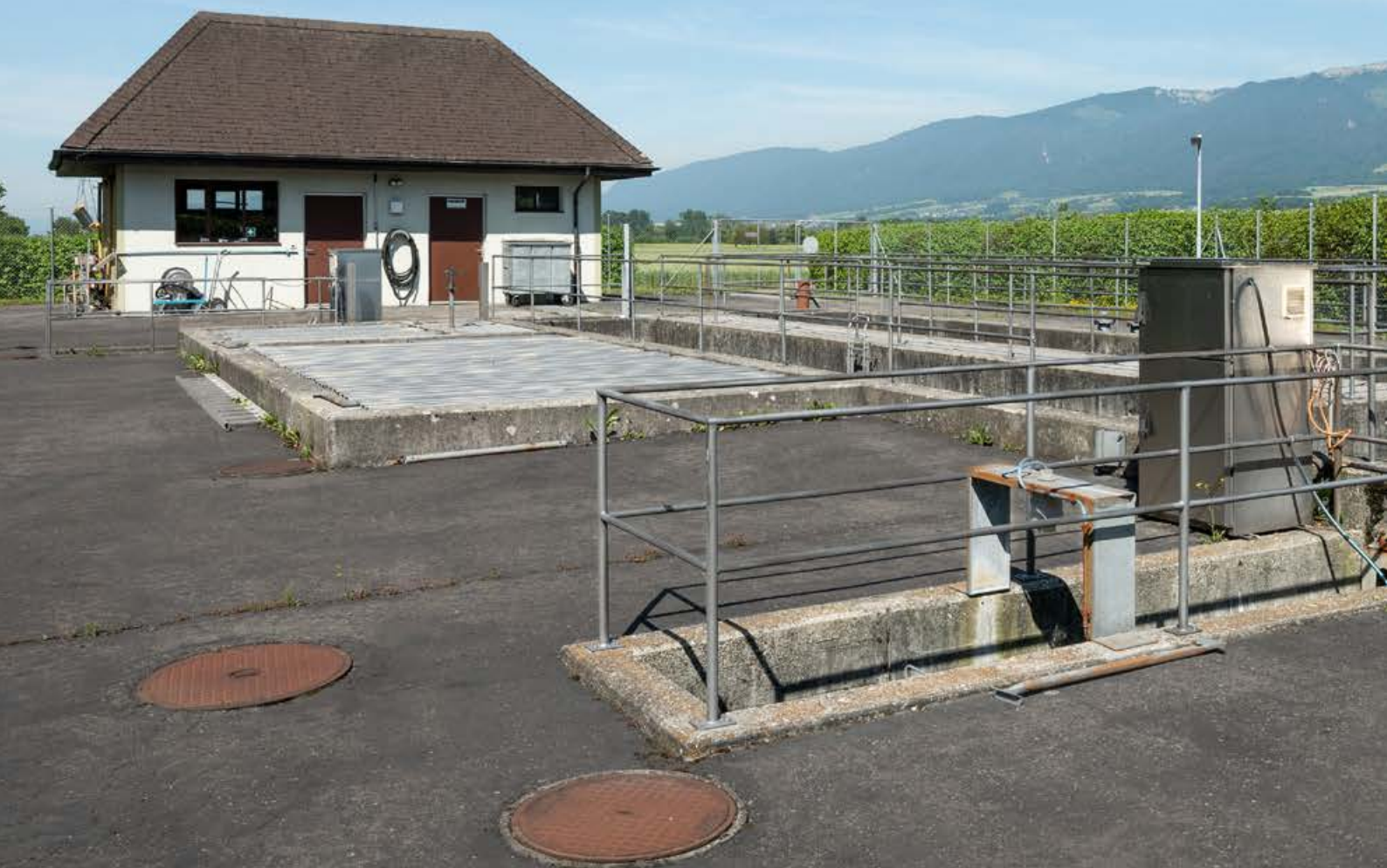
Alte Kläranlage Lüsslingen-Nennigkofen
