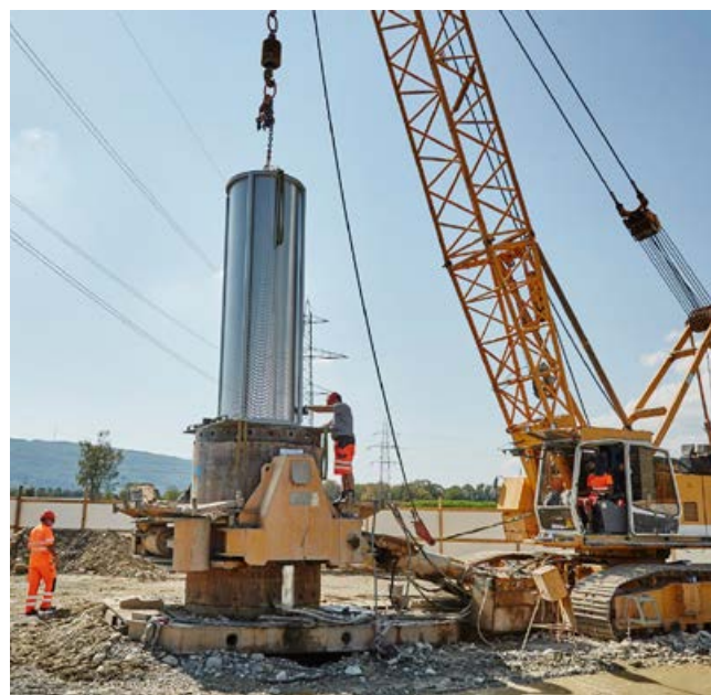
Filtereinbau (Æ1 200) mittels Seilbagger und Verrohrungsmaschine
