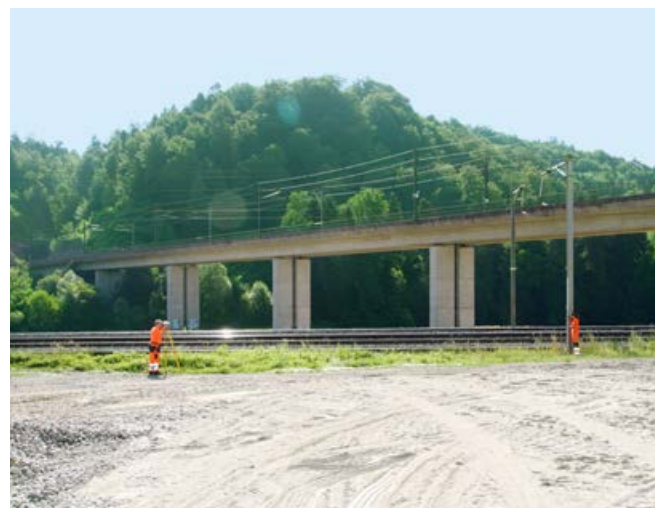
Messkampagne bei Murgbrücke zwischen Mattstetten und Rothrist
