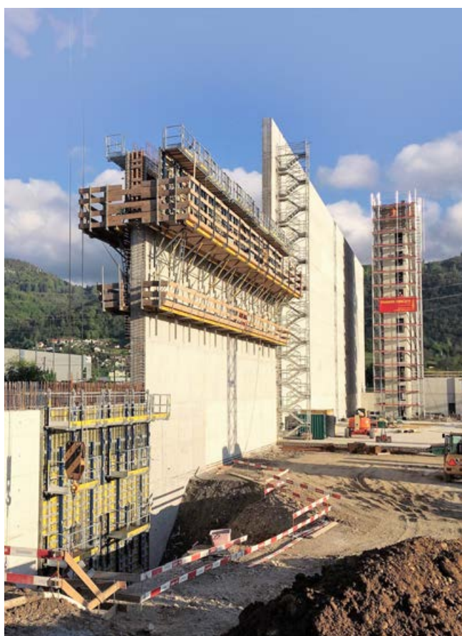
Brandwand zwischen Kommissionierungs- und Hochregallager
