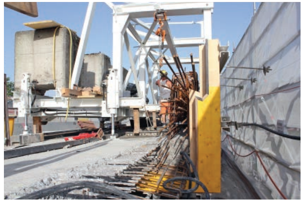
Abbruch und Neuerstellung der Randbordüre
