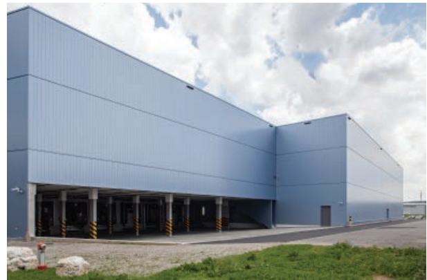
Logistikzentrum Fischer Papier Fulenbach, fertiggestellt, Ansicht Fassade West
