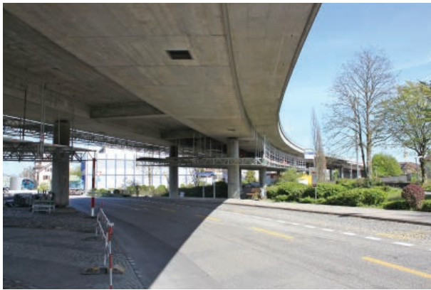
Hängegerüst zur Instandsetzung der Brückenuntersicht
