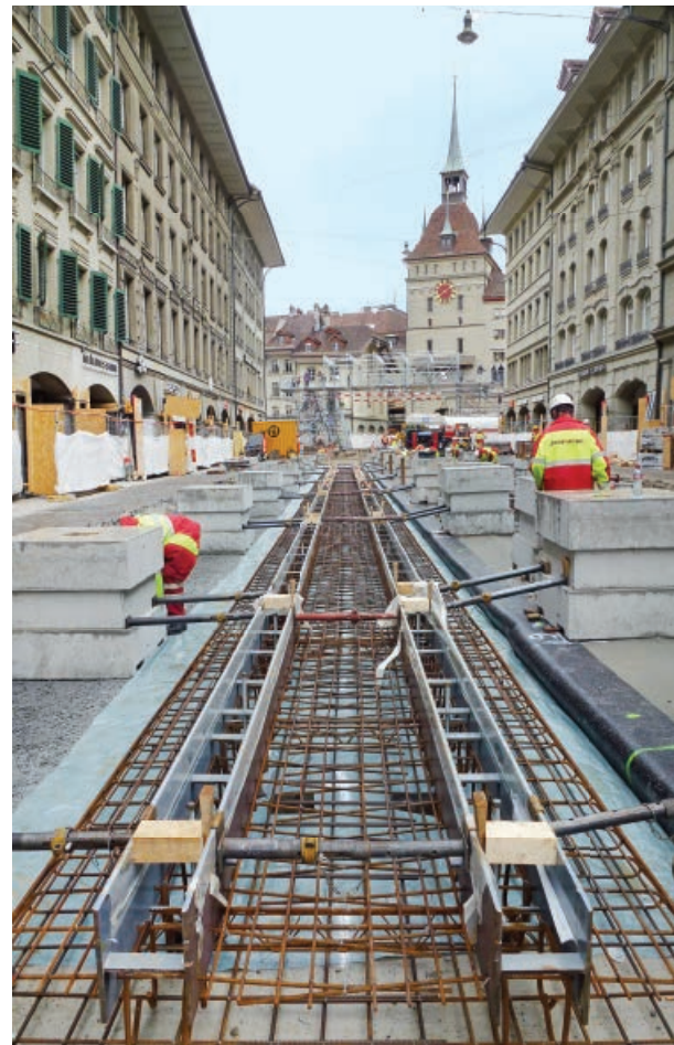
Gerichtete Stahlkanäle vor dem Betonieren
